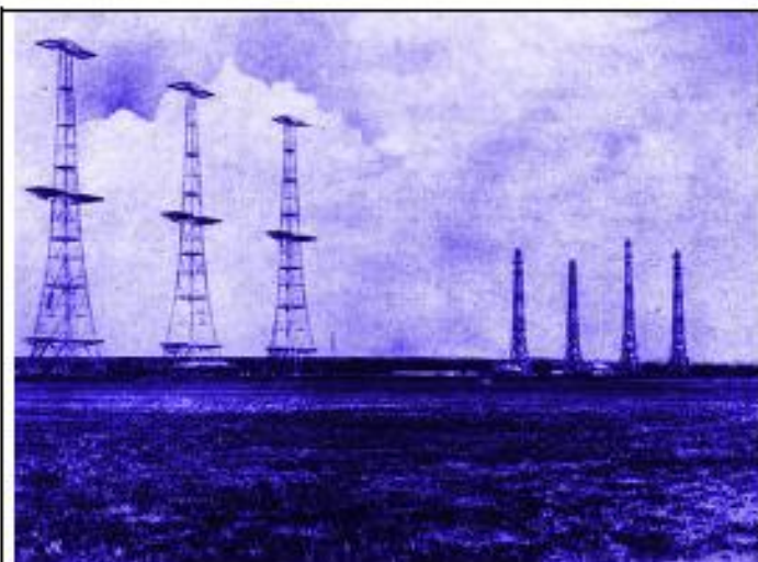
Ieri: le antenne RADAR costruite in Inghilterra dalla Compagnia Marconi a partire dal 1935.
