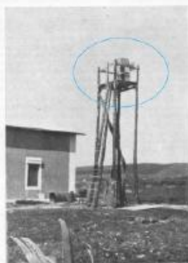
Torre Chiaruccia: sull'impalcatura la parabola usata da Marconi per gli esperimenti di radiolocalizzazione
